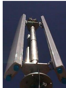
Suporte para antenas painel setorizadas
